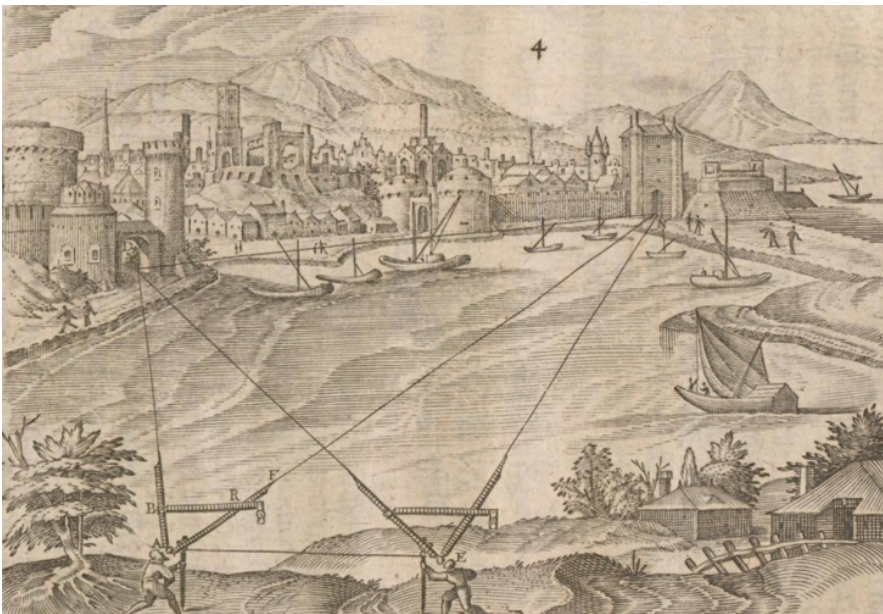
Abb. 1: Distanzmessung mit einem Triangularinstrument. Quelle: Benjamin Bramer: Apollonius Cattus , 3. Teil (4. Kapitel)
