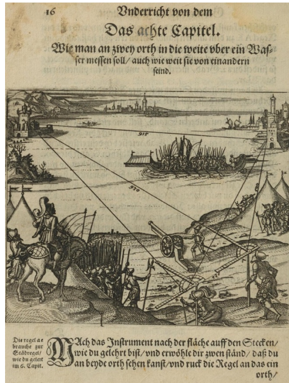
Abb. 5 (oben links): Vermessung mit einem geometrischen Instrument (Halbkreisscheibe mit Winkelmesser und Kompass und Proportionalwinkel mit drei Schenkeln). Quelle: Leonhard Zubler: Novum instrumentum geometricum (Seite 18)
